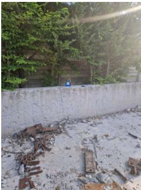
Foto prelievo lato est
