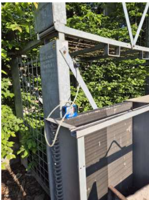
Foto prelievo lato nord
